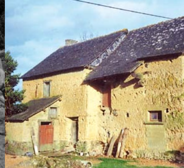
Le Puits Gaillard, bâtiment du XVII e s.
