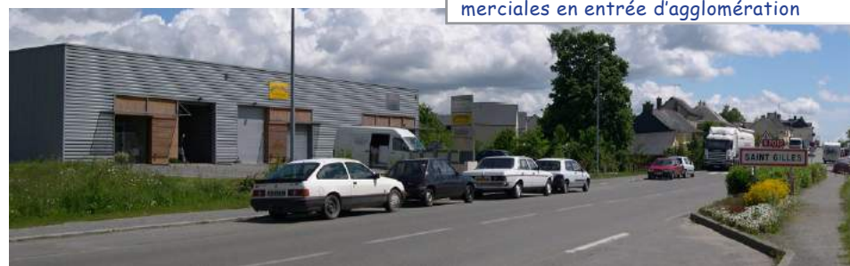
Traitement homogène des façades commerciales en entrée d'agglomération
