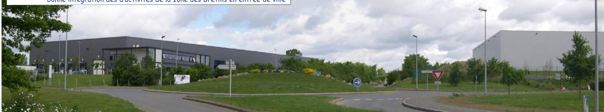
Aménagements paysagers et qualité architecturale des bâtiments favorisent la bonne intégration des d'activités de la zone des Bretins en entrée de ville
